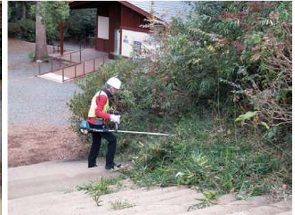
刈払機で階段脇の下草刈り
